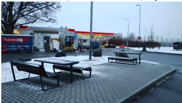
Obrázek č. 11: ČR, D1 Střechov km 52,1 vpravo
