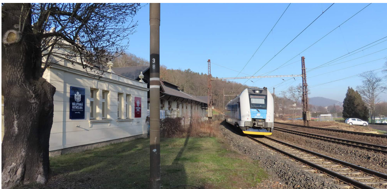
01 — Nástupiště zastávky Bílina kyselka budou situována v obdobné poloze jako stávající, vně traťových kolejí. Přístup na ně bude novým podchodem
