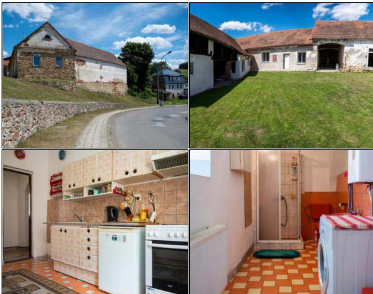
Obrázek č. 69 – Srovnávací nemovitost č. 1 – rekreační objekt
