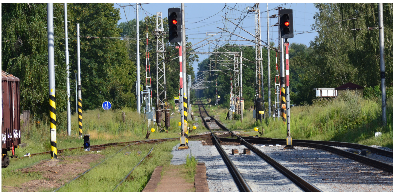
01 — Současná jednokolejná trať se rozšíří na dvoukolejku a dostane nové zabezpečení
