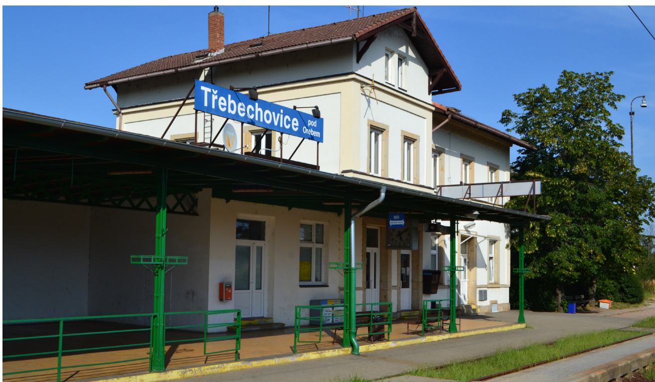
02 — Modernizací projdou i železniční stanice, nová budou nástupiště a přístup na ně
