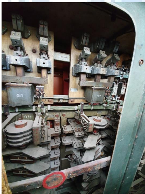
obr.12 Stav trakční přístrojové skříně
