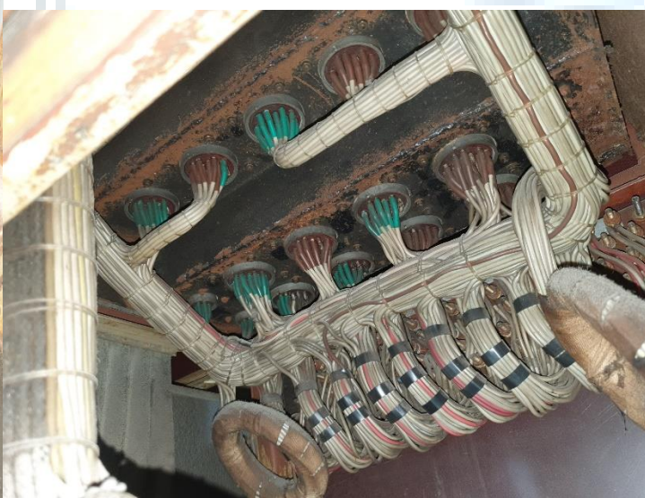
obr.17 Stav NN kabeláže mezistěny
