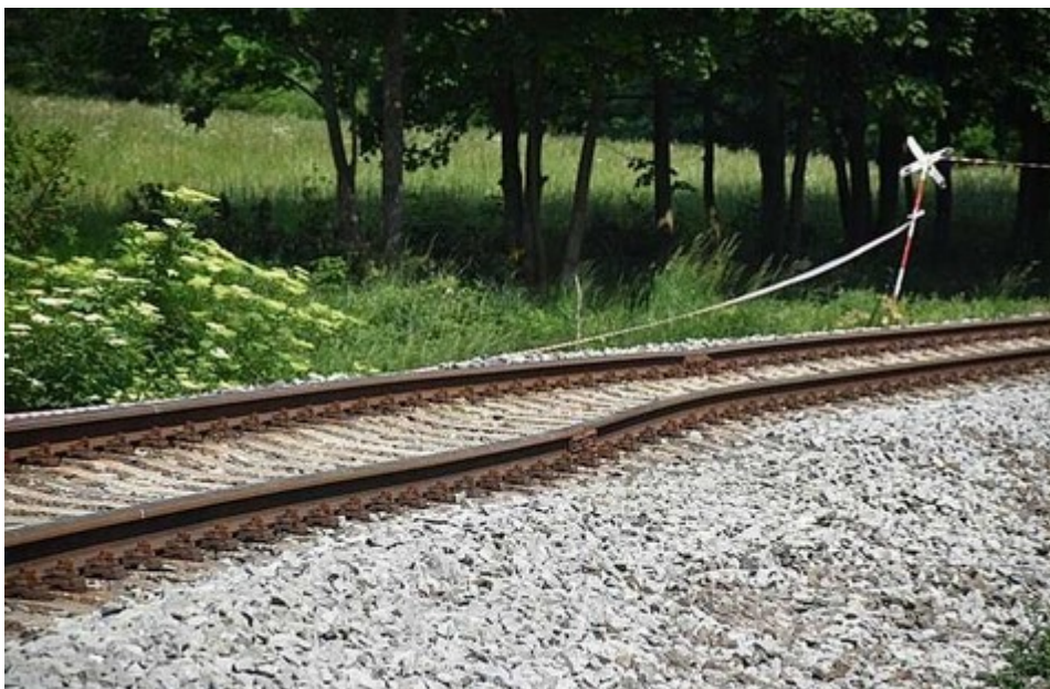
Obr. č. 4: Propad vnitřního kolejnicového pasu v místě vykolejení prvního podvozku.
