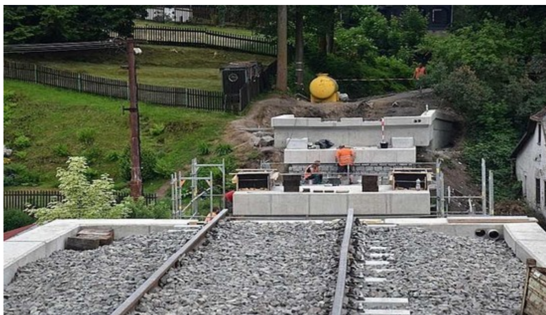
Obr. č. 3: Stavební otvor pro vložení NOK1 a NOK2 (pohled ze směru plánovaného vložení)
