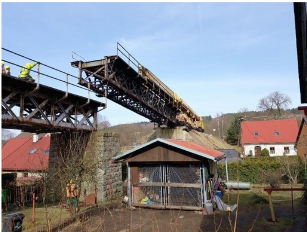
Obr. č. 10: Snášení starého mostu a jeho technický stav.
