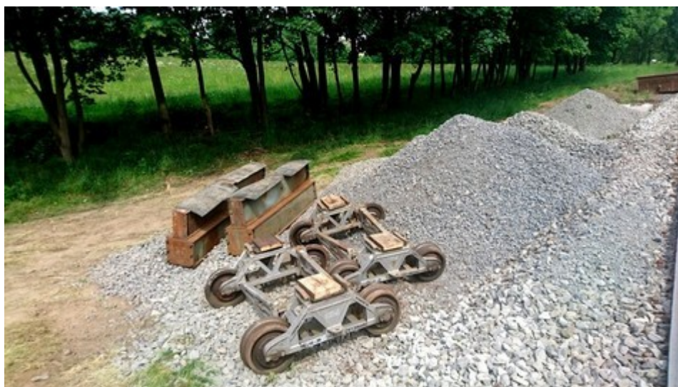
Obr. č. 5: Podvozky vzor 53 s úložnými trámcí se nacházely vlevo koleje na železničním přejezdu P3518 v km 9,964.
