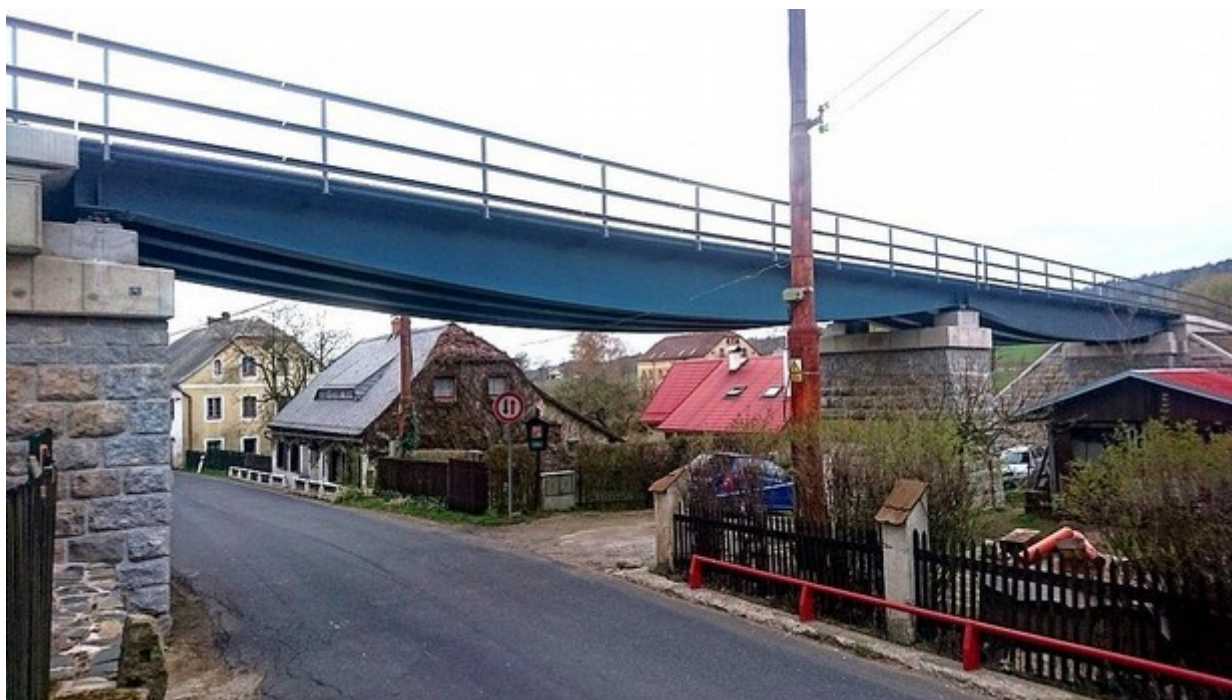
Obr. č. 11: Stav nového mostu.
